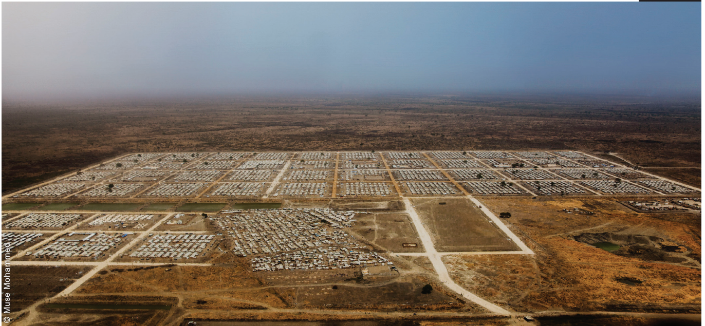
Le plan d'agrandissement englobait des terrains qui avaient déjà été spontanément occupés par des résidents du camp. Il a fallu organiser minutieusement par étapes les travaux majeurs de mise à niveau, car le site tout entier devait être réaménagé.
