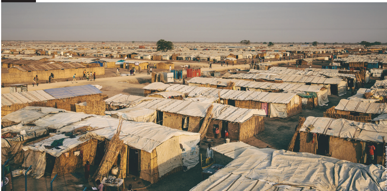
Des abris collectifs ont été construits dans le cadre du projet en raison du manque de terrains disponibles et de ressources nationales limitées. Ces abris permettaient d'optimiser l'utilisation de l'espace limité et ont influencé les stratégies en matière d'abris dans tout le pays.
