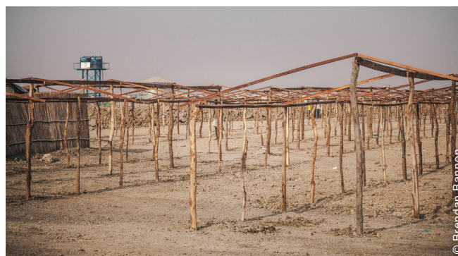
Les charpentes des abris ont été construites par des sous-traitants.
