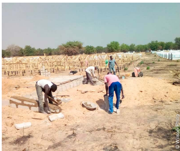
La construction d'abris et de latrines a débuté en octobre 2017, en prévision de la réinstallation prévue en janvier 2018 (par la suite avancée à la mi-décembre 2017).
