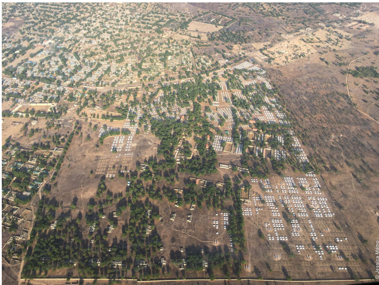
Vue aérienne du camp du GSSSS durant sa mise en place. Le camp, situé en périphérie de la ville de Bama, a été créé en vue de réinstaller des personnes déplacées internes.
