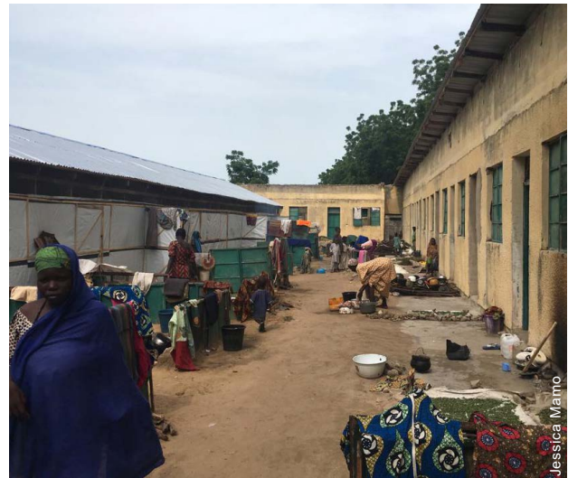
Des bâtiments existants sur le site ont été remis en état et compartimentés (à droite) en vue de fournir des abris supplémentaires dans le camp. Par ailleurs, des abris collectifs compartimentés (à gauche) ont été construits en raison du manque d'espace nécessaire pour accueillir des abris familiaux individuels.
