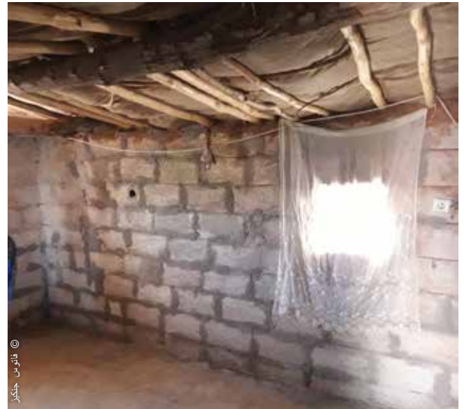
شملت أعمال الإصلاح عزل الأسقف وترميم الجدران والأعمال الكهربائية وإصلاح الأرضيات والسباكة واستبدال الأبواب والنوافذ.
